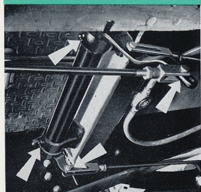
Fig. 98 - Graissage de l'axe et des chapes sur renvoi arrière de frein à main.
